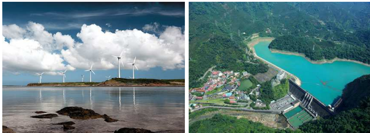
台灣再生能源蘊藏量依序以風力、太陽能與水力最多。圖為澎湖中屯風力發電廠與明潭水力發電廠。（影像來源：台灣電力公司，台電之美攝影比賽得獎作品）
