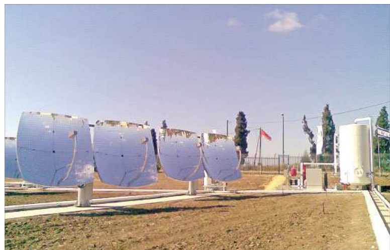
因光電池板吸收日照轉換電力時產生高溫，系統另接有管線輸送冷卻水，為光電池板降溫。冷卻水另由管道回流至儲水槽，成為供工業與家庭用的熱水。
