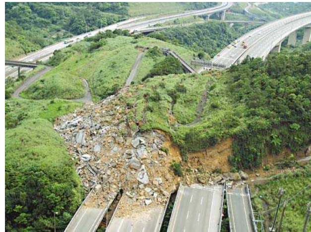
圖一：山崩現場
